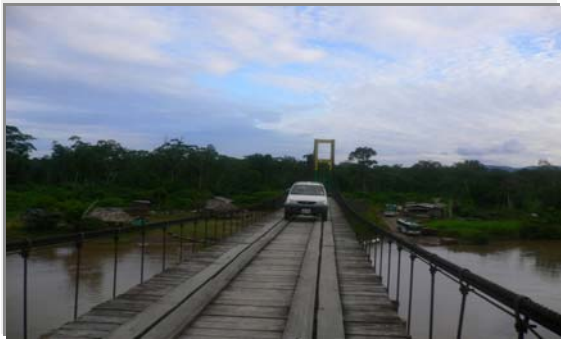
PUENTE PARA VEHÍCULOS LIVIANOS Y BUSES ESPERANDO LA GABARRA EN MORONA
